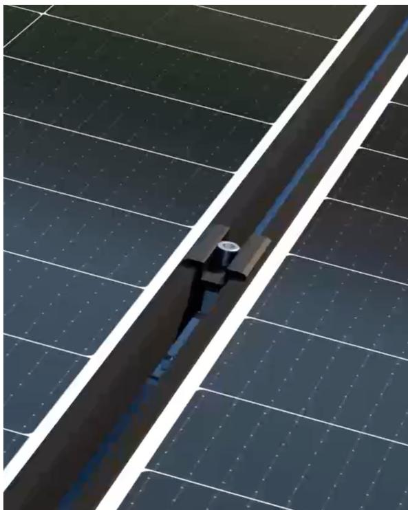
Legen Sie das Modul auf den Schienen ab, schieben es an das zuvor montierte Modul heran und richten es entsprechend aus. Schieben Sie nun 2 weitere Endklemmen in die Aluminiumschienen bis zum Modul heran und fixieren diese mit 16 Nm.
