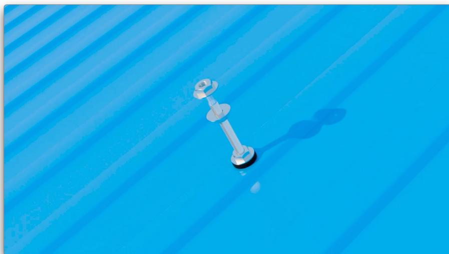
Verschrauben Sie die Stockschrauben, bis der Gummi das Blechdach erreicht und mäßig gequetscht wird.
